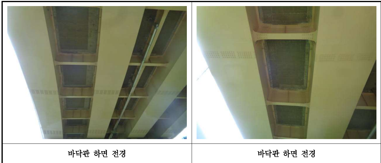
【사진 18.3.2】 바닥판하면 전경
