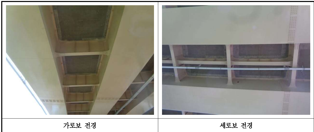
【사진 18.3.6】 가로보 및 세로보 전경
