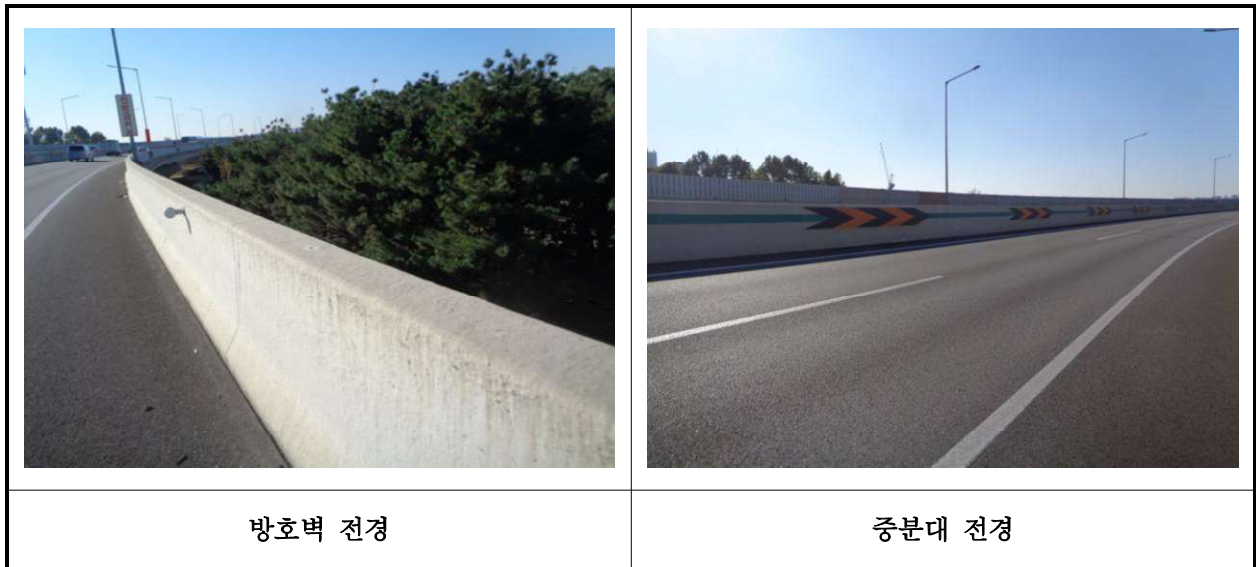
【사진 18.3.23】 방호벽 및 중앙분리대 전경
