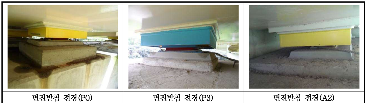
【사진 18.3.12】 교량받침 전경
