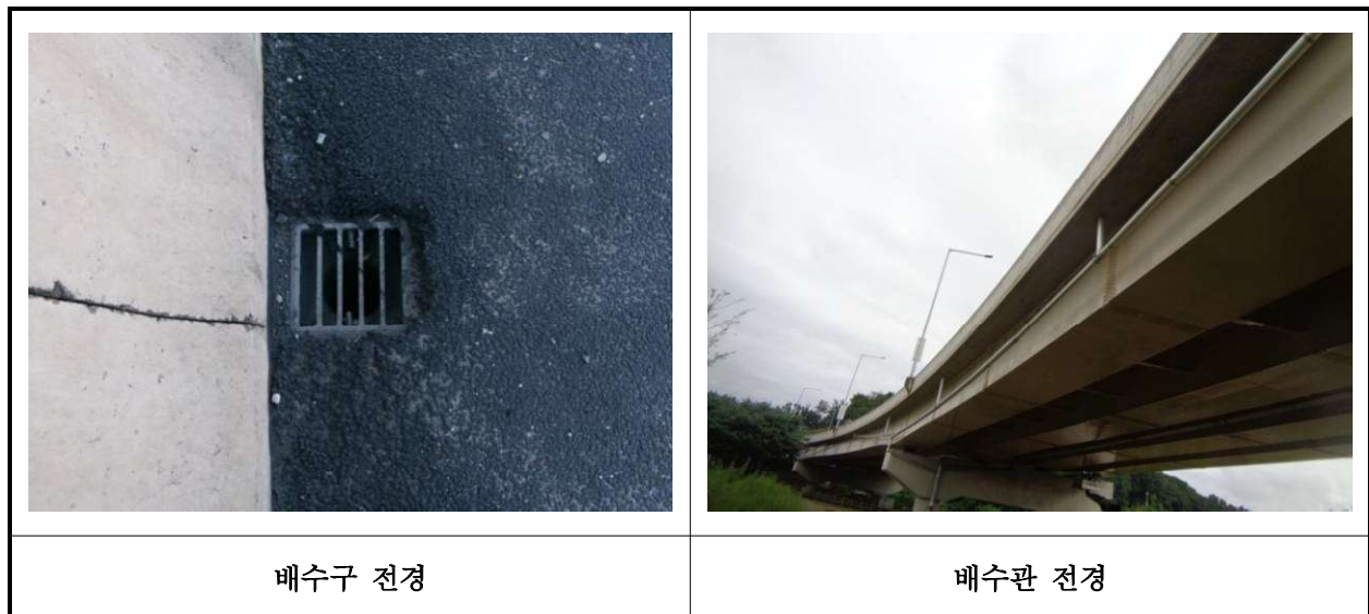
【사진 18.3.21】 배수시설 전경
