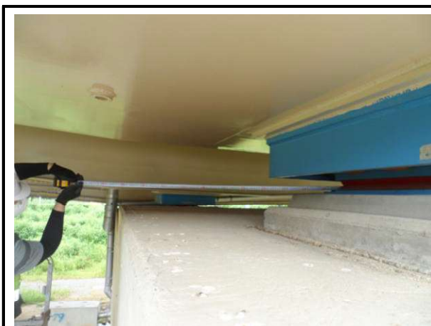
받침장치 연단거리 측정
