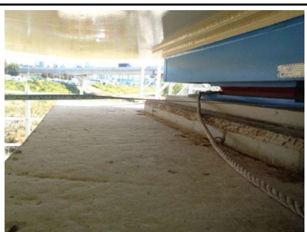
받침장치 연단거리 측정
