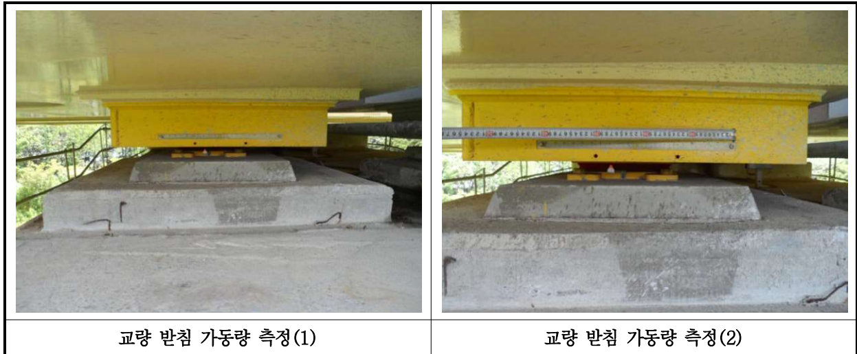
【사진 18.3.15】 교량받침 이동량 측정
