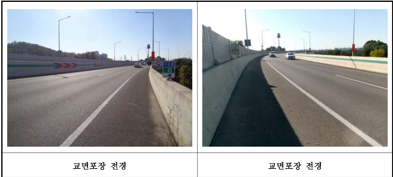
【사진 18.3.19】 교면포장 전경
