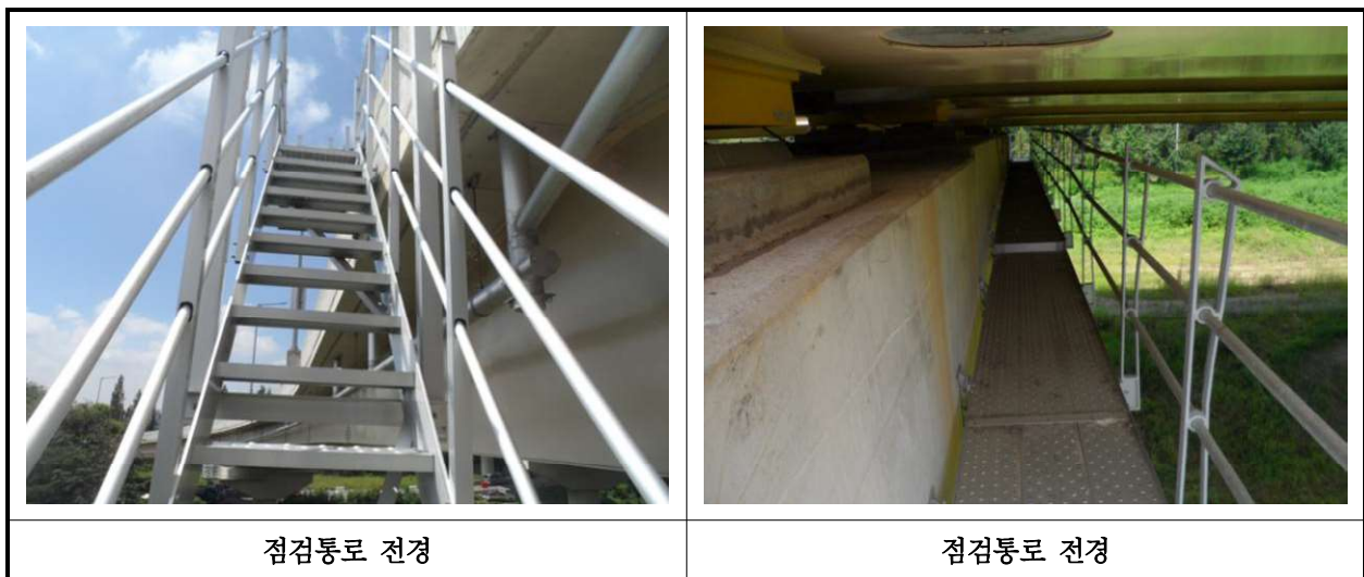
【사진 18.3.25】 교량 점검시설 전경
