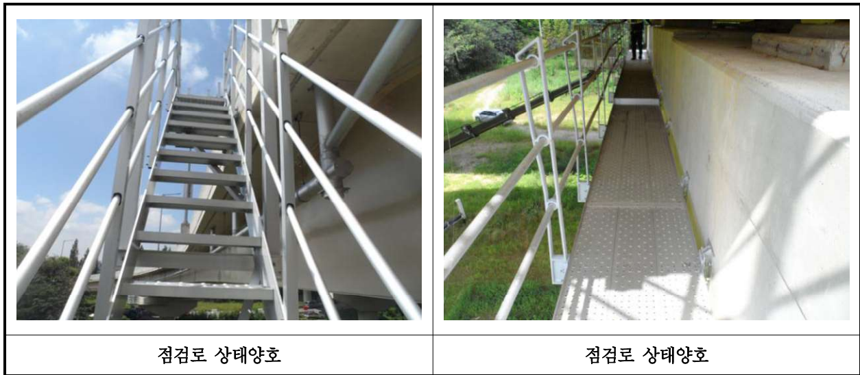
【사진 18.3.26】 교량 점검시설 손상현황
